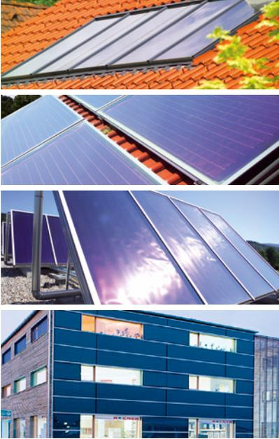
Die häufigste Montageart im Neubau ist die Indach-Montage, bei der die Solaranlage direkt in das Dach integriert wird und als angenehmer Nebeneffekt Dachziegel gespart werden.
