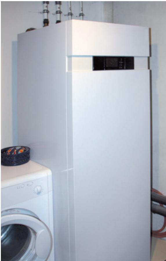
Der Einbau einer Wärmepumpe in einem bestehenden Gebäude, dessen Dämmstandard nicht dem heutigen Stand der Technik entspricht und in dem Heizkörper für die Wärmeabgabe installiert sind, ist im Vorfeld fachkundig zu prüfen. Zumeist sollte zunächst eine umfassende thermische Sanierung des Gebäudes durchgeführt werden.
